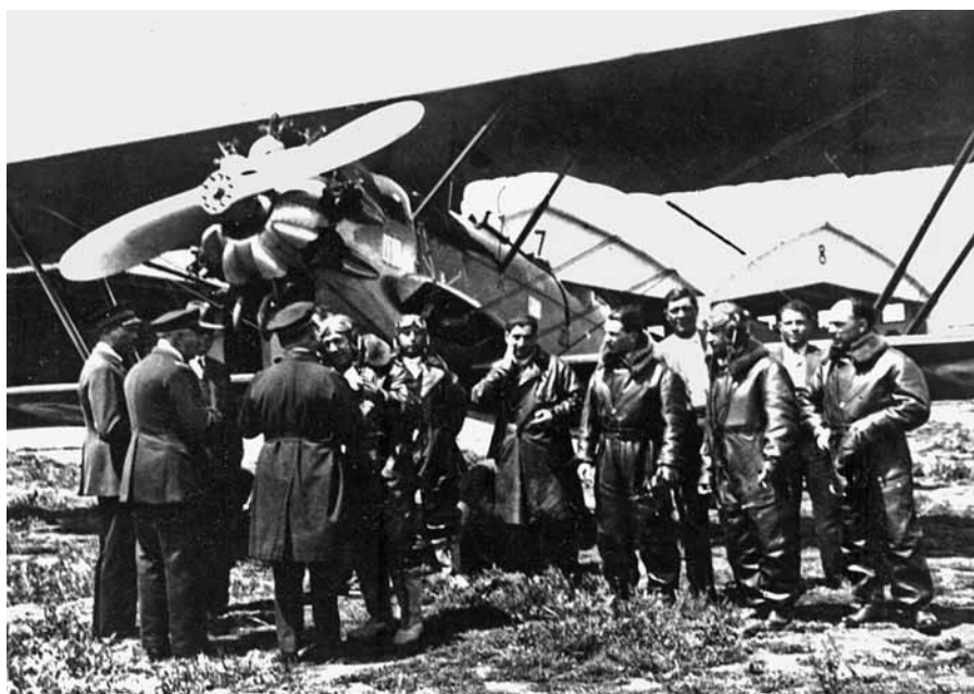
Após a aterragem no campo de Cazes, em Casablanca
